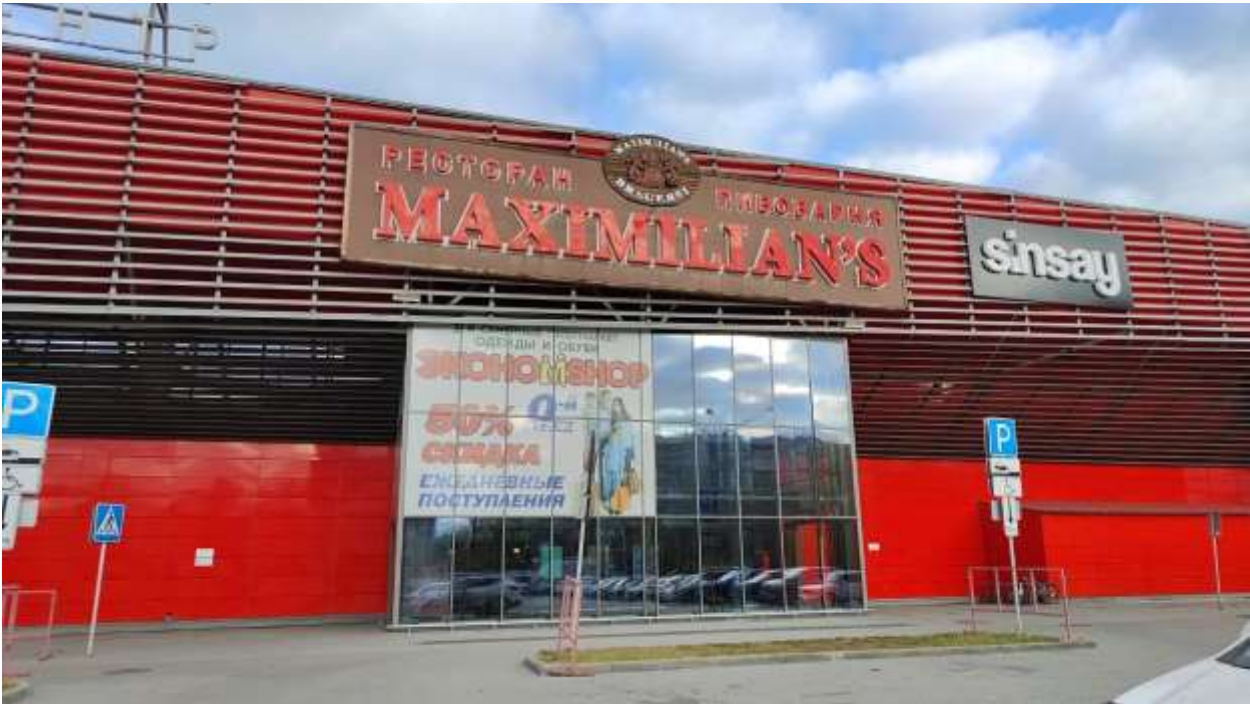
Фото № 2. Нежилое здание с кадастровым номером 54:35:032600:120
