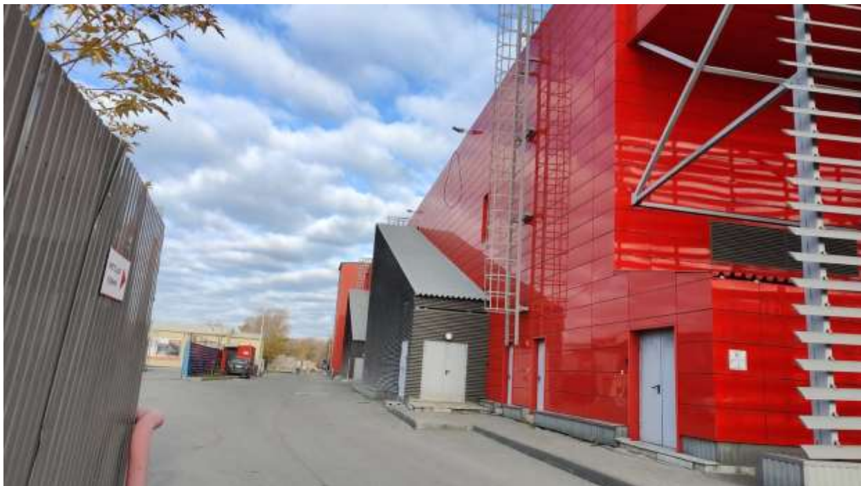
Фото № 4. Нежилое здание с кадастровым номером 54:35:032600:120
