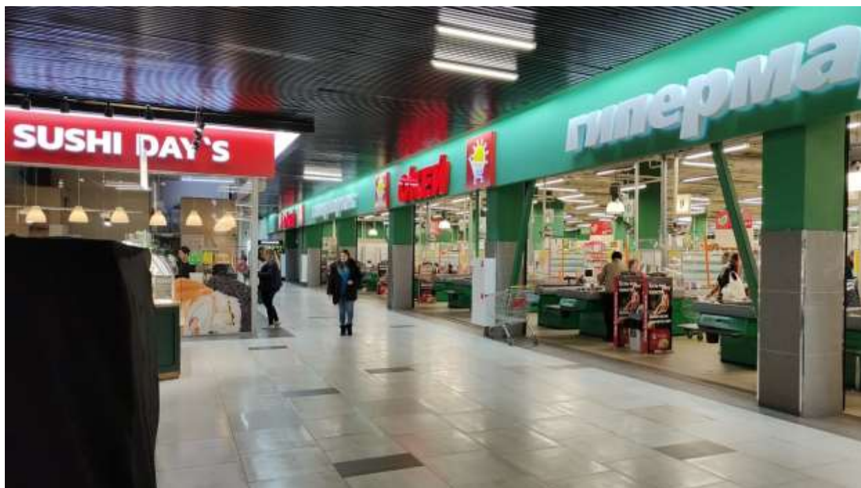
Фото № 8. Нежилое здание с кадастровым номером 54:35:032600:120
