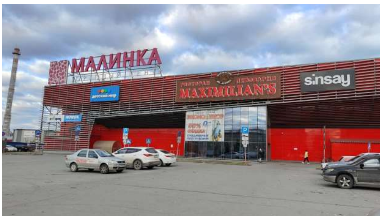
Фото № 1. Нежилое здание с кадастровым номером 54:35:032600:120
