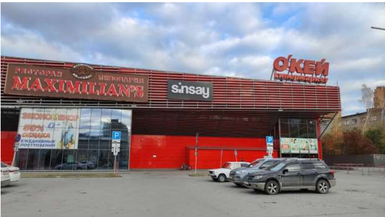
Фото № 3. Нежилое здание с кадастровым номером 54:35:032600:120
